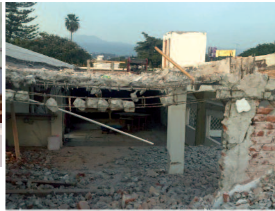
Après le séisme, il a fallu démolir une partie des bâtiments.
